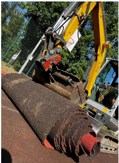
Ausbau Kunststofflaufbahn
